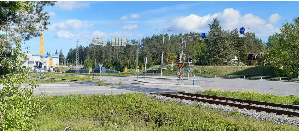
Kuva radan ja valtatie yltä kohti etelää. Oikealla kaavamuutosalueella sijaitseva asuinrakennus.
