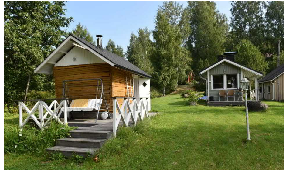
Kuva: Vasemmanpuoleinen hirsisauna on peruskorjattu. Oikeanpuoleinen sauna on rakennettu alkuperäisen kaltaisena ja kokoisena 2000-luvun puolella.
