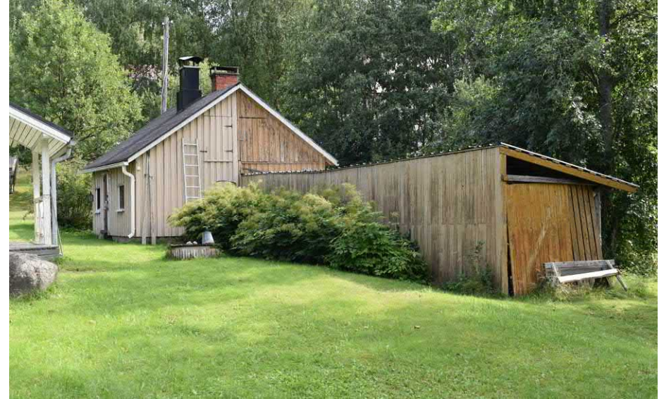
Kuva: Väinölän ja Mikkolan saunarakennuksessa on kaksi omalla sisäänkäynnillä olevaa saunaa. Tilanraja kulkee rakennuksen halki harjalinjalla.
