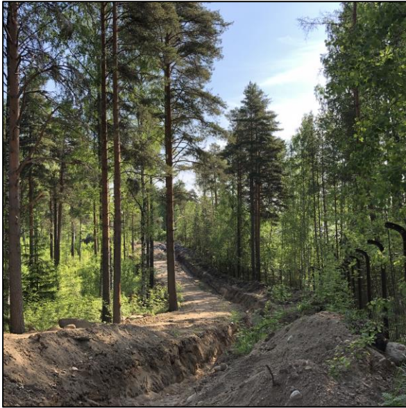
Kuva 2 ja 3. Alueella on tehty maasähkökaapelien asentamiseen liittyviä kaivuutöitä.
