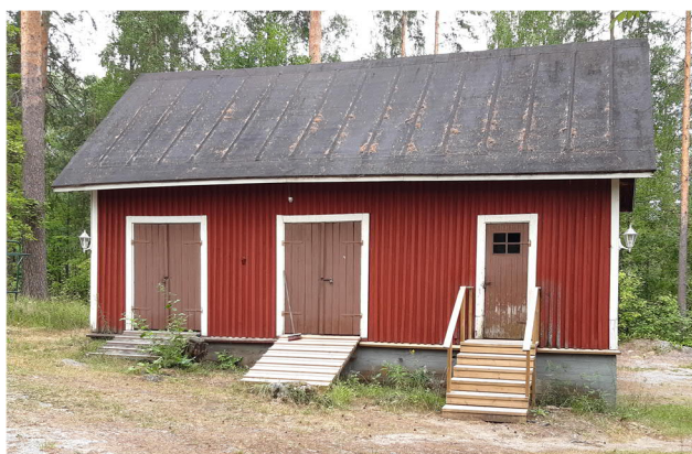
Metsäkonttorinkuja 6, talousrakennus etelästä.
