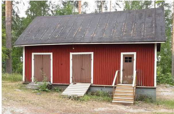
Metsäkonttorinkuja 6, talousrakennus etelästä.
