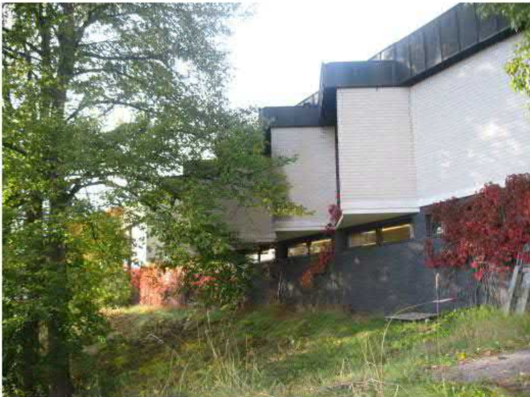
Entisen kirjaston julkisivu Pihlajaveden suuntaan, sokkelin yläosassa lehtienlukusalin ikkunat. Lehtilukusaliin on järjestetty tilapäisesti päivähoitotoimintoja.
