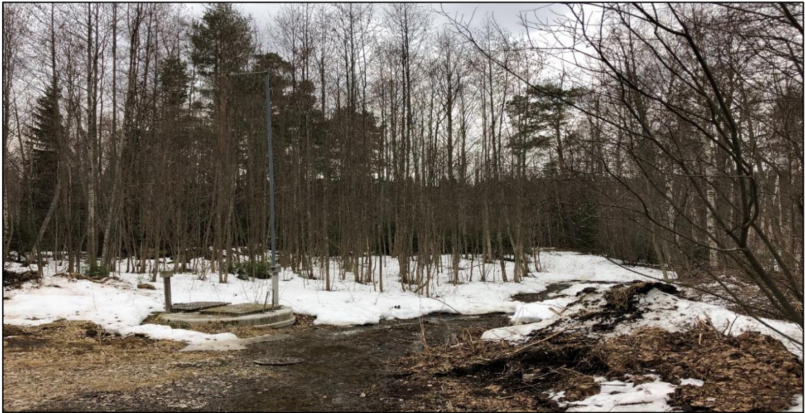
Kaivertamontien pohjoispäässä oleva pumppuasema ja Saharannantiehen yhtyvän traktoriuran alku.
