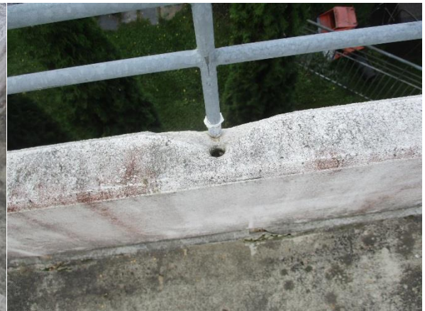
Kaiteen kiinnitys irronnut
