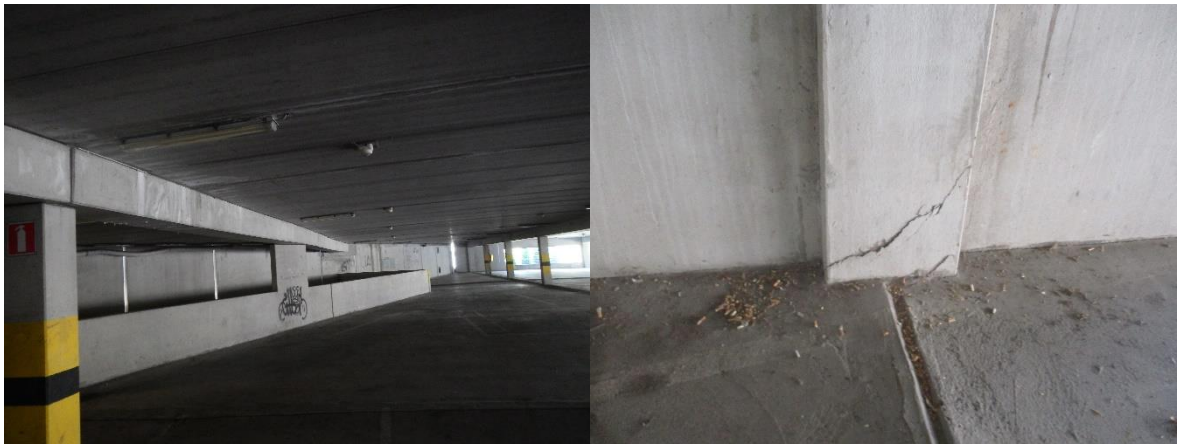
Yleiskuva sisäpuolen pilari-palkkirakenteista Pilarissa lohkeama
