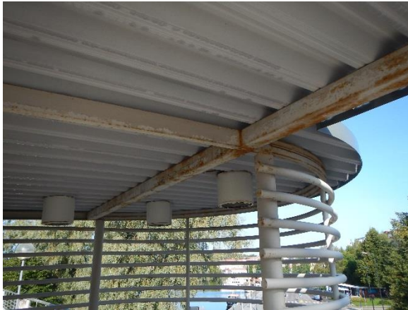
Korroosiota teräsrakenteissa
