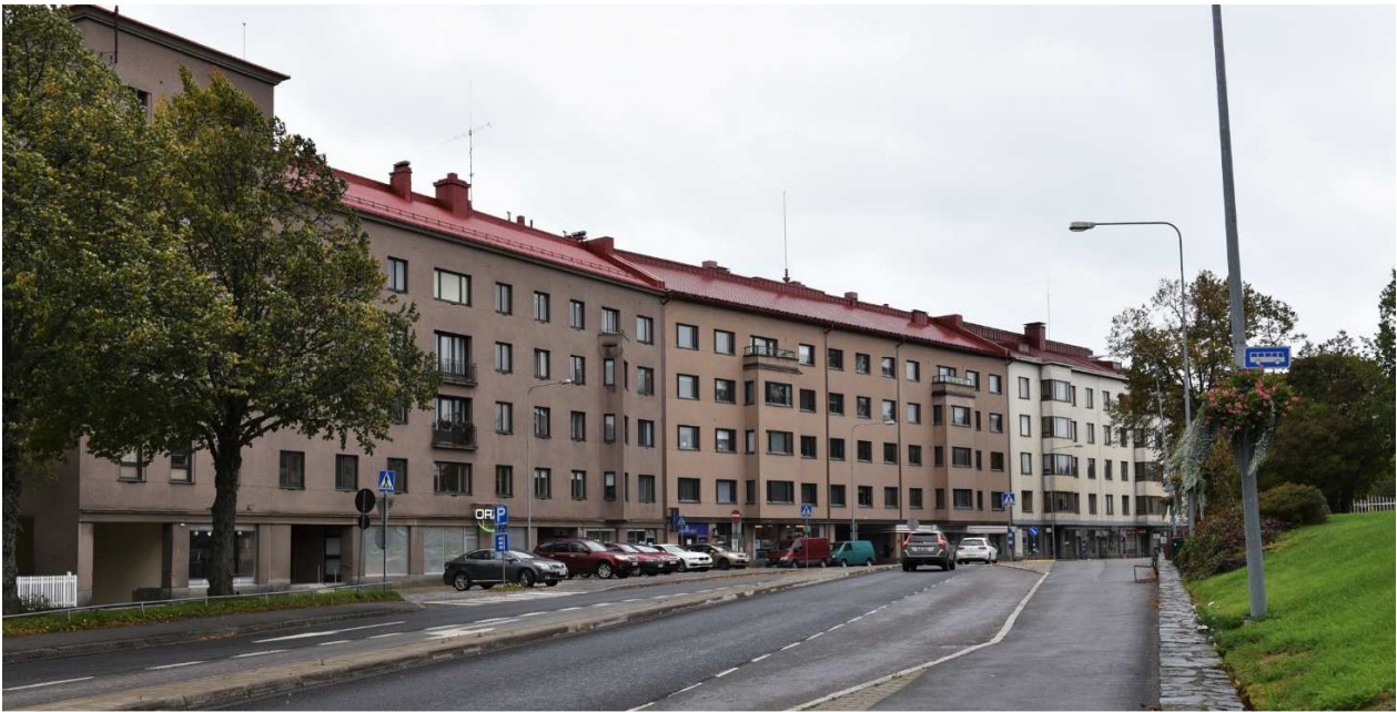
Kuva: Yhtenäinen kaupunkikuva: Kivitalokorttelin Olavintorin puoleinen katujulkisivu.
