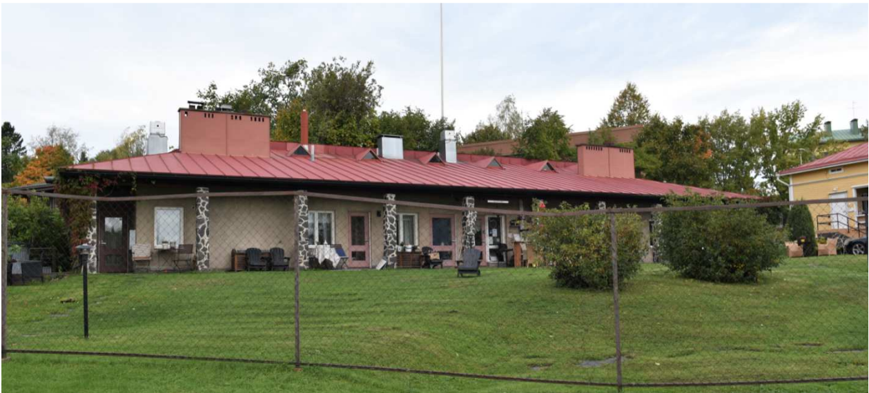
Kuva: Vanhassa lauttarannassa on talousrakennuksesta tehty majoitusrakennus. Nykyasu on 40-luvulta.
