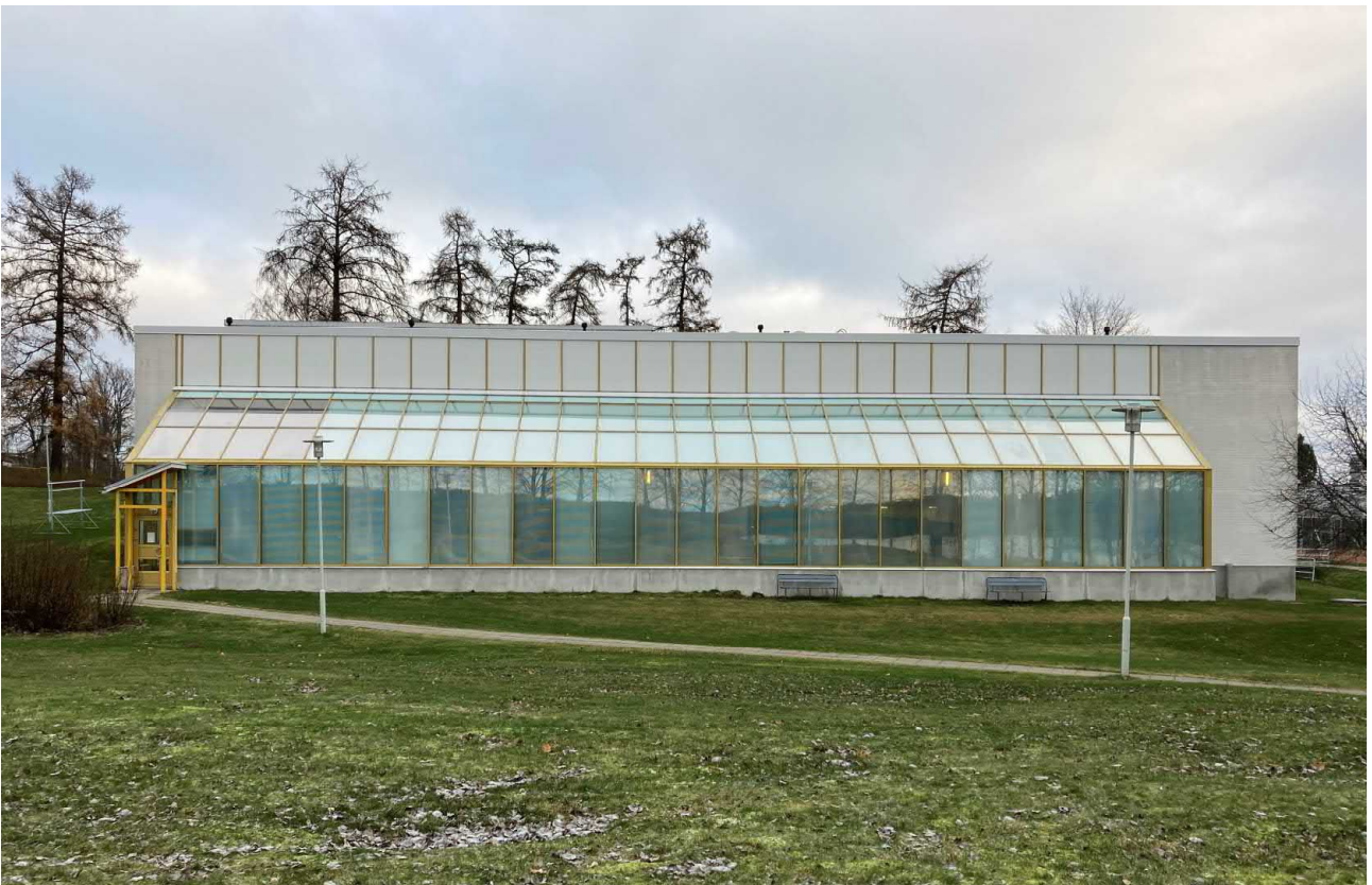
Kuva 6. Allashuoneen laajennus uimahallin lounaissivulla.
