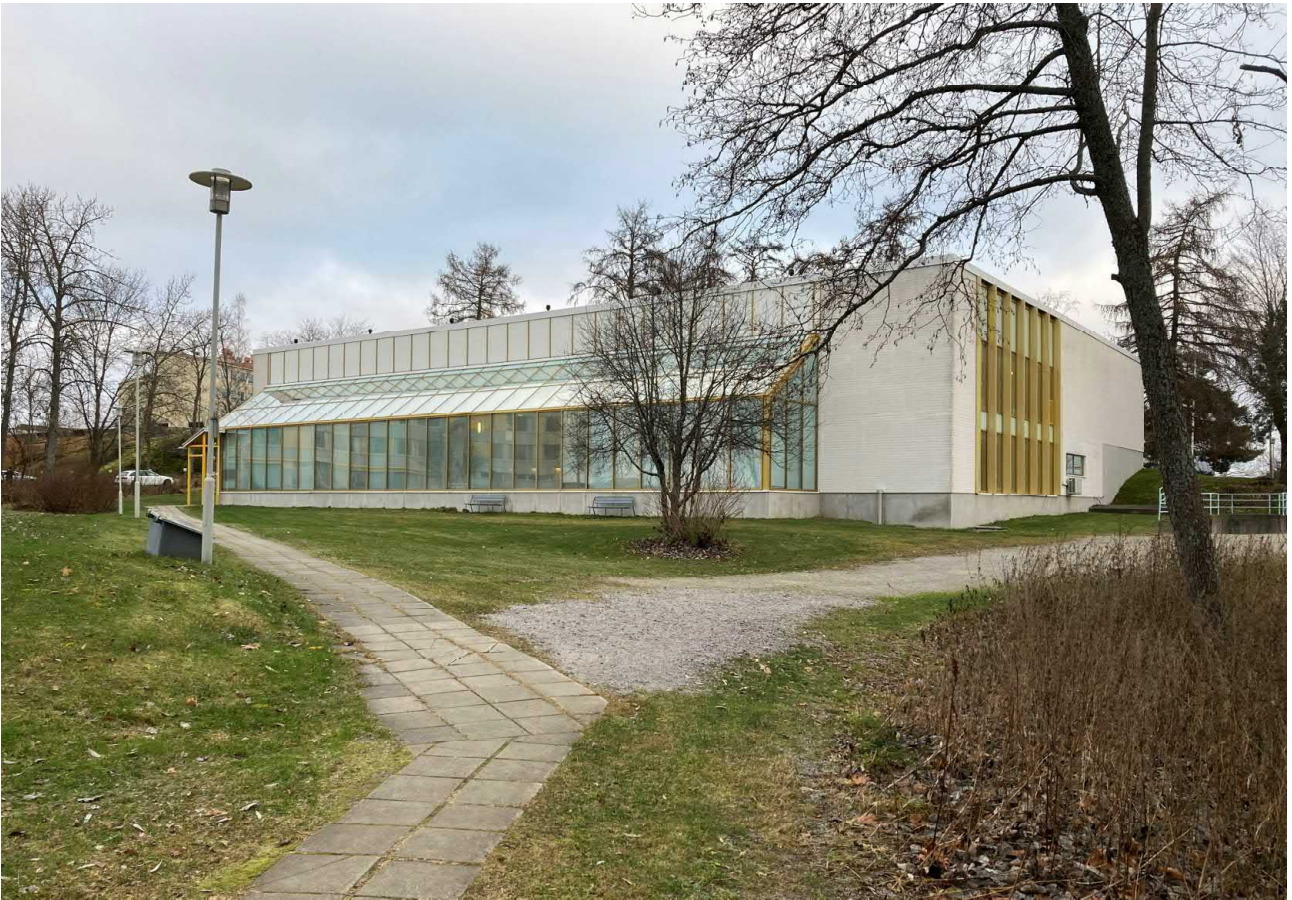
Kuva 7. Uimahallilta rantaan laiturille ja avantouintipaikalle johtava polku.
