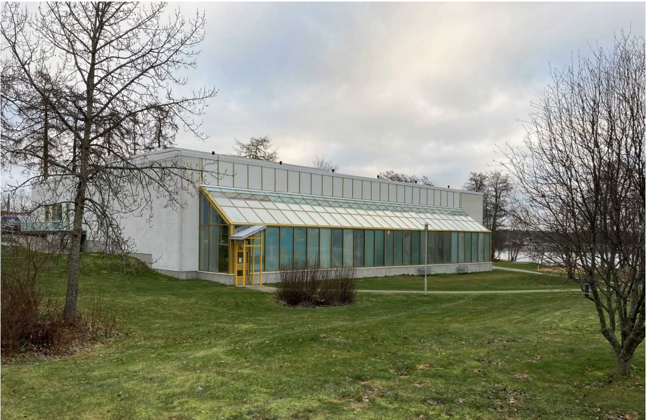
Kuva 5. Uimahallin luoteis- ja lounaisjulkisivut.
