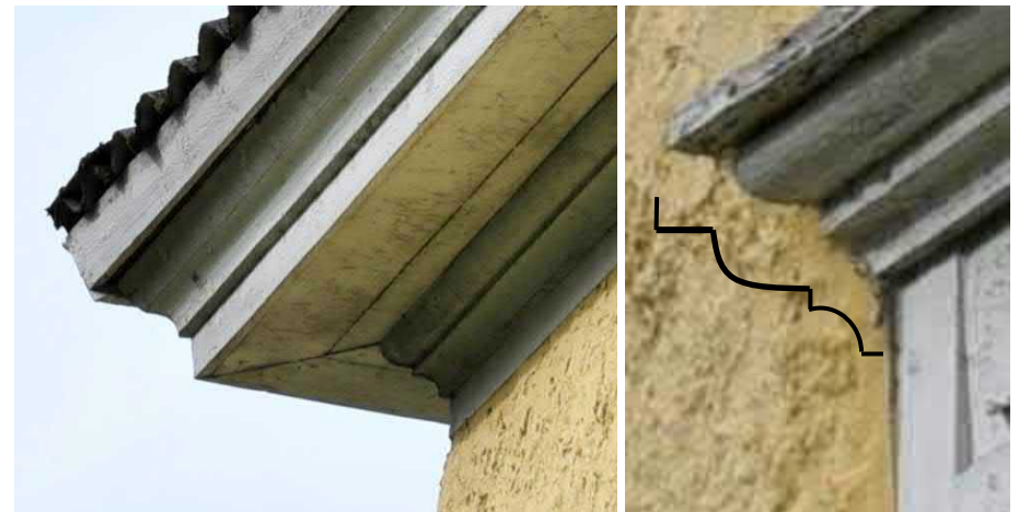
Kuva: Rästään ja seinän liitoksessa ja ikkunaotsikossa on käytetty samoja listamalleja.
