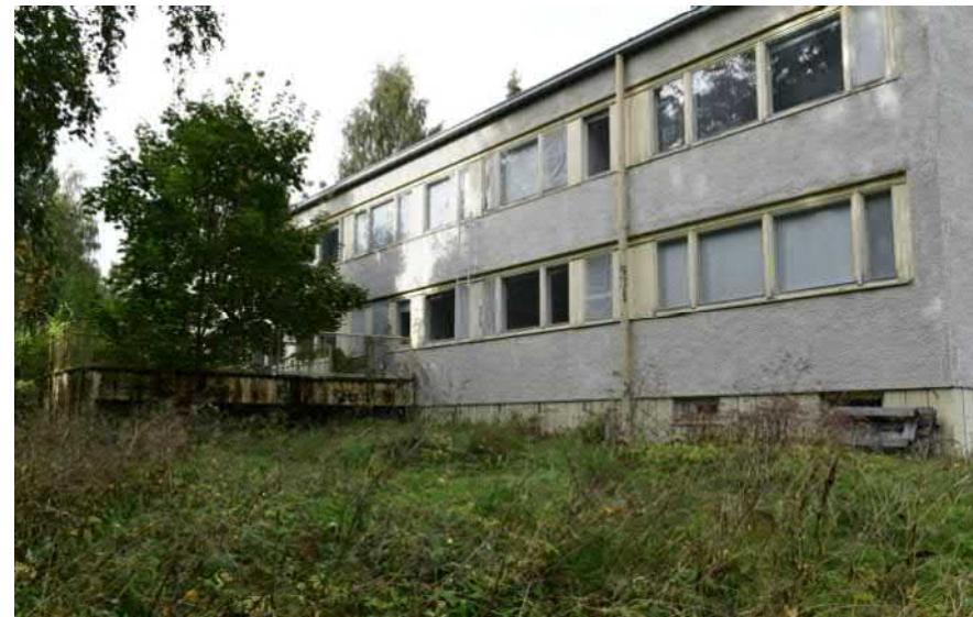
Kuva: Rannan puoleisella sivulla on ollut pilariperustainen terassi ja sen jatkeena lasiterassi. Nauhaikkunoita ryhmittävät puusäleiköt ovat kantavien pilareiden kohdilla.
