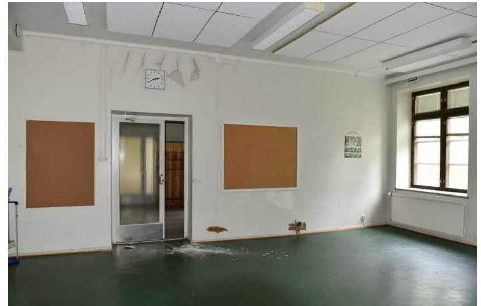
Kuva: I-kerroksen luokkahuone.
