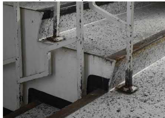
Kuva: Metallikaiteen pinnat liittyvät askelmiin.
