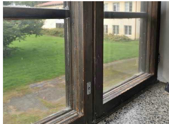
Kuva: Ikkunat uusittu 70-luvulla. Syvä ikkunapenkki on mosaiikkibetonia
