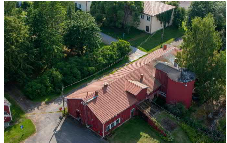
Kuva: Karjarakennuksen AIV-torni on rakennettu 70-luvulla rakennuksen tienpuoleiselle sivulle.
