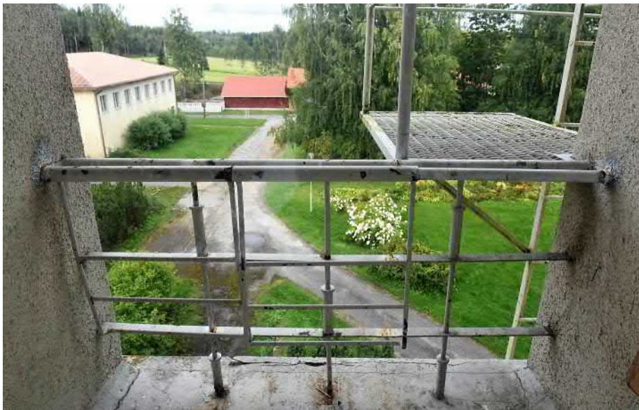
Kuva: Alkuperäinen pyöröputkesta "rullakoristein" tehty tuuletusparvekkeen kaide. Ulkopuolella jälkeen päin lisätty metallisilta seinätikkaille (häätäuloskäynti 70-luvulta).
