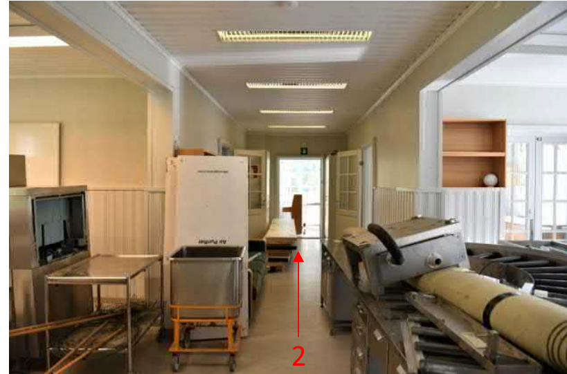
Kuva: Keskikäytävä ei enää jatku yhtenäisenä talon läpi. Väliseiniin on tehty aukot.
