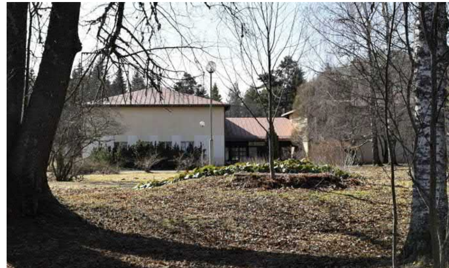
Kuva: Rakennuksen pääsisäänkäynti on sisäpihan eli puiston puolella.
