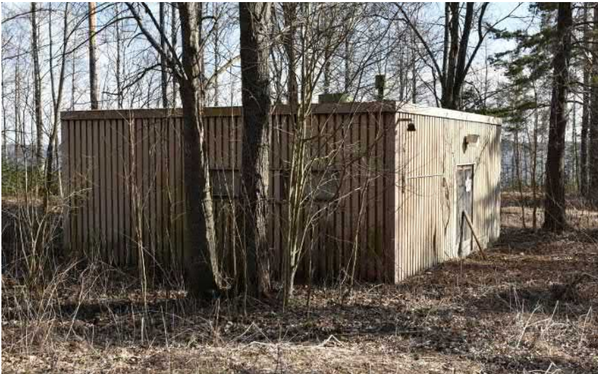
Kuva: Vedenottamon kopperirakennus etelärannan laiturille vievän tilustien varrella.
