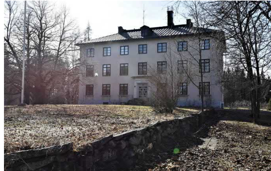
Kuva: Julkisivu itään. Etualalla kivimuuri.
