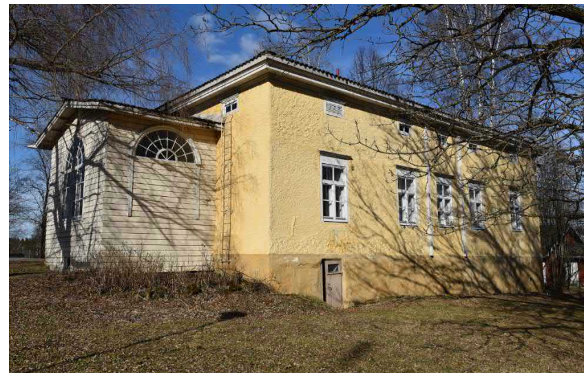
Kuva: Rakennuksen järvenpuoleinen julkisivu eli eteläsivu ja länsipääty.
