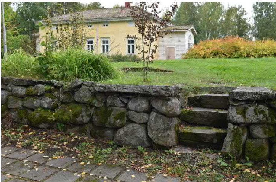
Kuva: Etupihan tukimuurissa päällimmäisenä on isot laattamaiset luonnonkivet.
