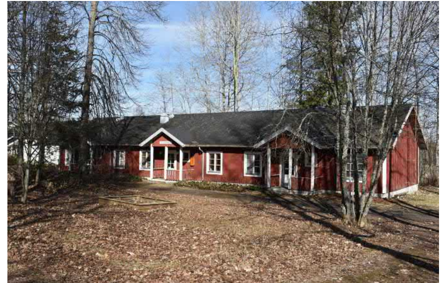
Kuva: Talonpoika – oppilasasuntola (pohjoisempi taloista)
