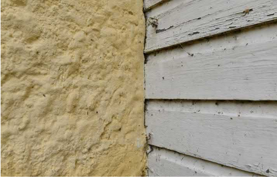
Kuva: Julkisivumateriaalit: rappaus ja avosaumainen vaakalauta. Päätyosien seinälaudoitus menee rappauksen sisään. Myös ikkunoiden vuorilaudat jäävät rappauksen pintaa hieman syvemmälle, mutta otsikot nousevat esille. .
