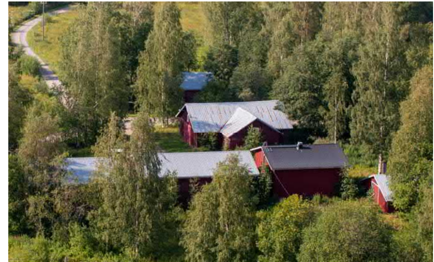
Kuva: Kuivaamo- ja konehallipihan kaikki rakennukset. / SL:n kaupungin ilmakuvat.
