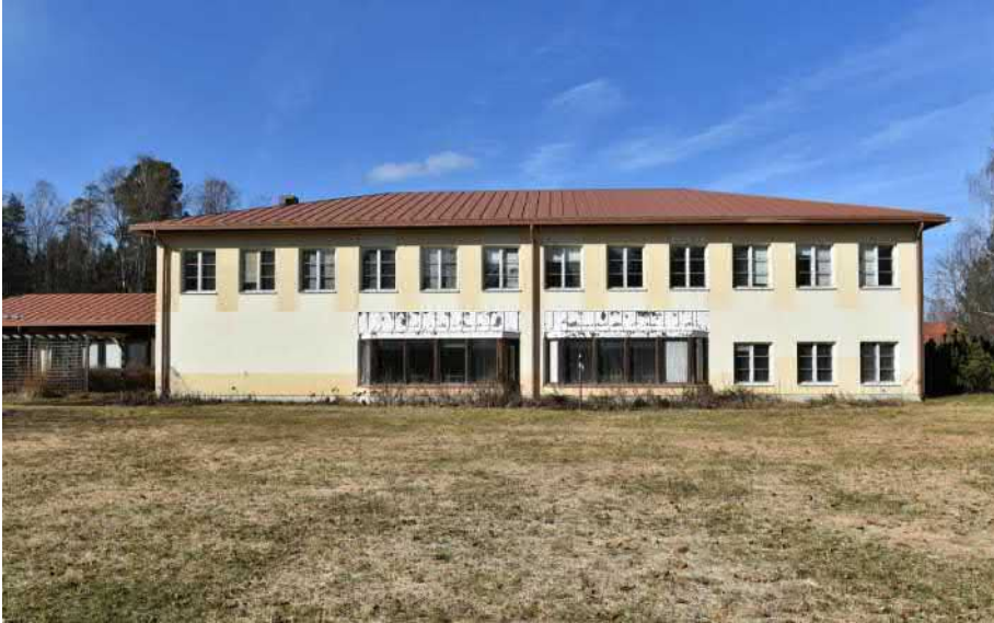
Kuva: Eteläfasadi puutarhan suuntaan.
