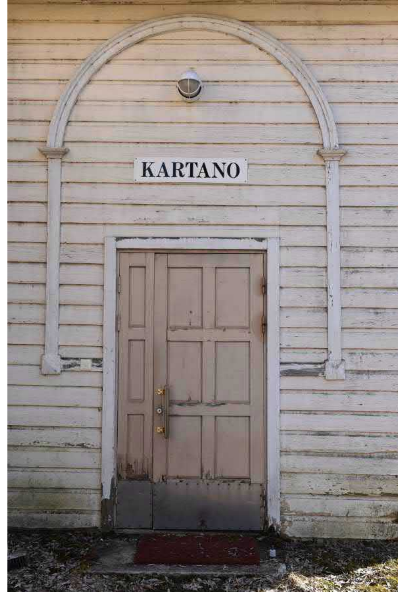
Kuva: Nykyisessä puisessa ulko-ovessa on ulkopinnassa pintapeilit ja sisäpuolella pystypaneeli.
