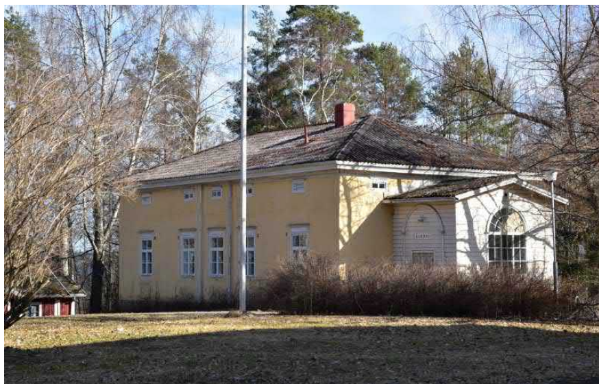
Kuva: Pääfasadi pohjoiseen ja länsipääty. Mikäli varttikate on asennettu ennen 90-lukua, niin siinä on mitä todennäköisimmin asbestia.
