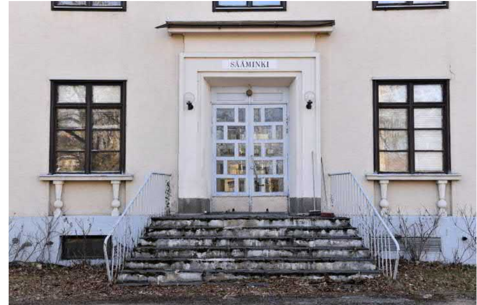
Kuva: Kaarevan betoniportaan tilalla on suora liuskekevillä päällystetty betoniporras. Portaan uusimisen yhteydessä teetetty uudet alkuperäisten kaltaiset metallikaiteet (pyöröputki, -tanko), joissa kuitenkin pinnat tiheämmässä. Art deco -tyylinen ulko-ovi.
