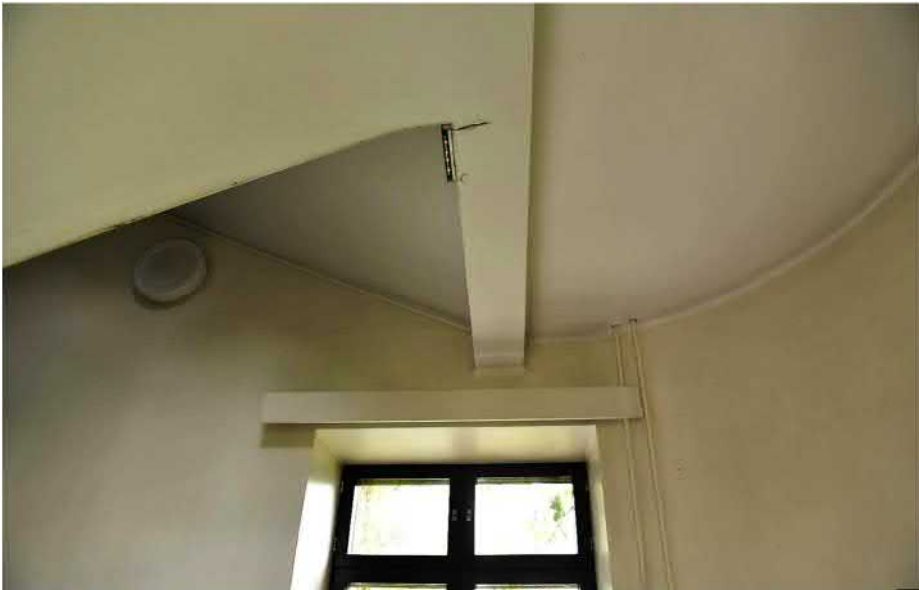
Kuva: Lepotasanteen katossa palkki ja siihen liittyvä porrassyöksy.
