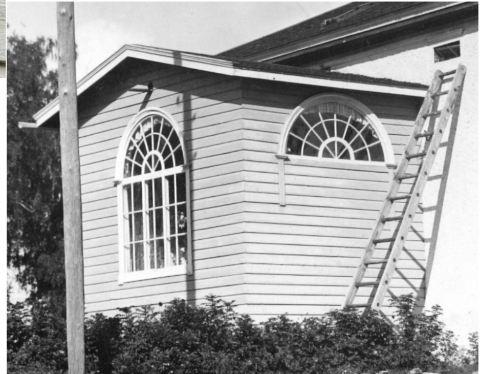
Kuva: Länsipäädyn puukuisti, ehkä 40-50-luvulta. Toinen "pilastereista" on katkennut./ Savonlinnan maakuntamuseon kuva-arkisto, kuvan osasuurennos.
