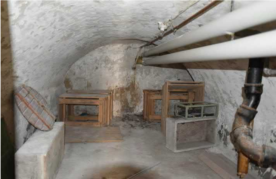
Kuva: Pinnoiltaan rapattu holvikellari, jonne on käynti talon eteläsivun kivijalasta.
