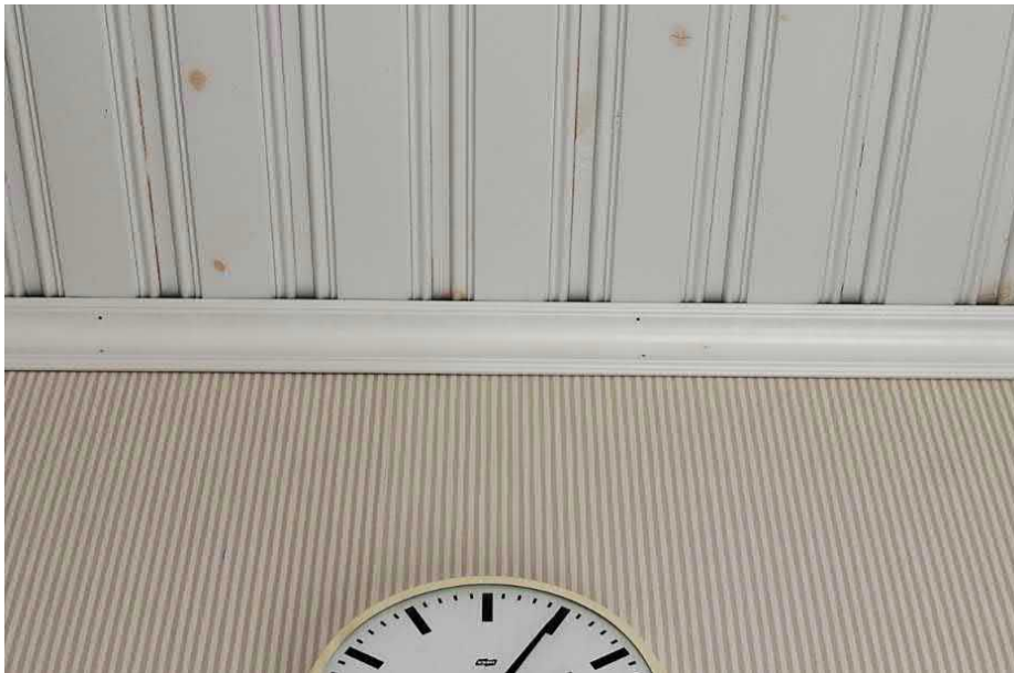
Kuva: Tapetoitu seinä, katossa on kaksoishelmiponttista paneeli ja reunassa holkkalista.
