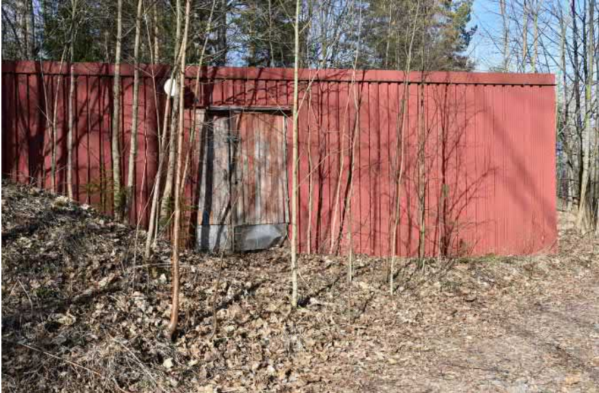
Kuva: Entinen jäteveden puhdistamo, samoin kuin vedenottamo, sijaitsivat kartanon eteläpuolella. Molemmat on rakennettu 1974. Puhdistamo saneerattiin ja samalla laajennettiin 2 m verran pituussuunnassa 1982 (RL 99/1981). Rakennuksessa on pulpettikatto, vesikate poimulevyä ja seinissä profiloidut teräslevyt.
