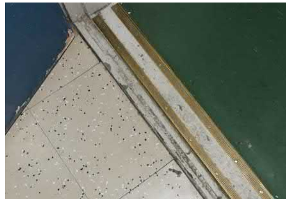
Kuva: Lattiapäällysteitä I- ja II-kerroksessa.
