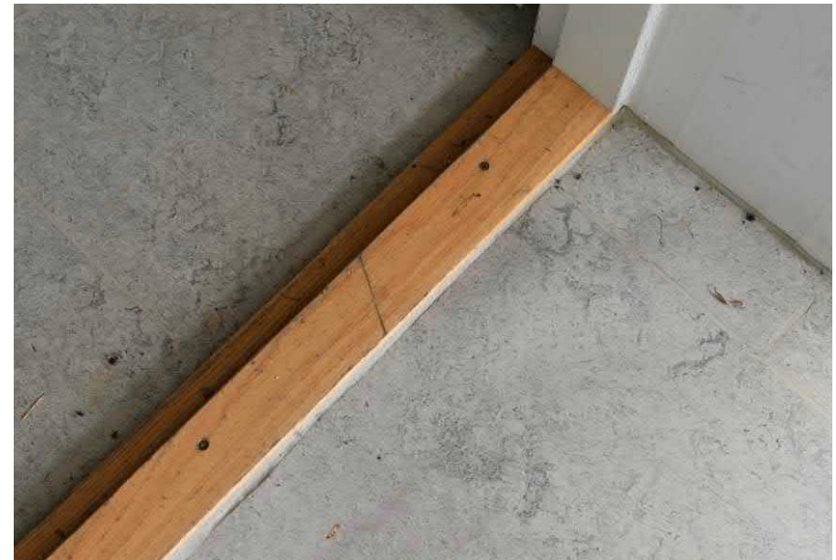
Kuva: Kapea puinen kynnyks. Linoleumi lattiasa.
