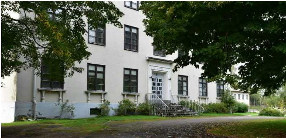
Kuva: Ikkunoiden vaihdon yhteydessä peittomaalaus vaihtui kuultosävytykseen. Ikkunoiden alapuoliset balusterit on tehty kipsistä ja rapattu.
