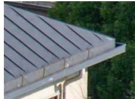
Kuva: Sadevesijärjestelmä on uusittu alkuperäisen kaltaisena: räystäään reunalla oleva peltiränni ja räystäskourut, joissa alun perin oli suppilot.
