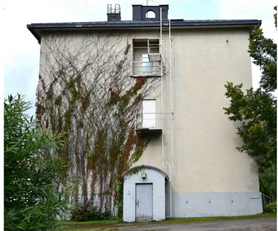
Kuva: Rakennuksen eteläpäädyssä on kellarin sisäänkäynti. II-kerroksen parveke ja hätäuloskäynti on lisätty jälkeempään.
