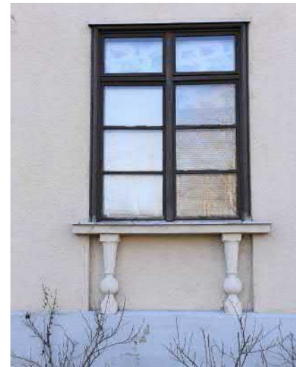
Kuva: Balustradin aiheima I-kerroksessa.
