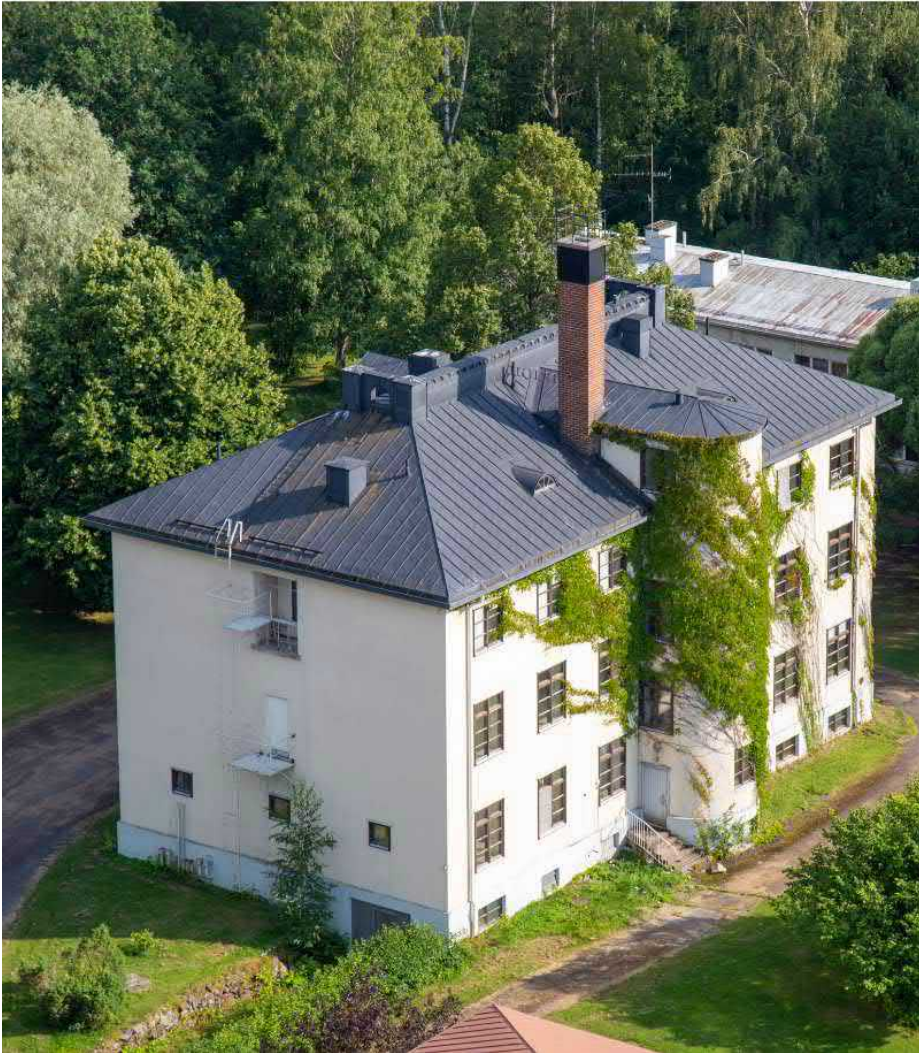
Kuva: Pohjoispäädyssä on jäljellä yhdet pariovet. Toinen oviaukko on poistettu ja tilaan tehty öljysäiliö. Rakennuksen katon harjalla olevassa kotelossa on poistoilmahormit. Julkisivuremontin yhteydessä on poistettu seinistä korvausilmaventtiilit.
