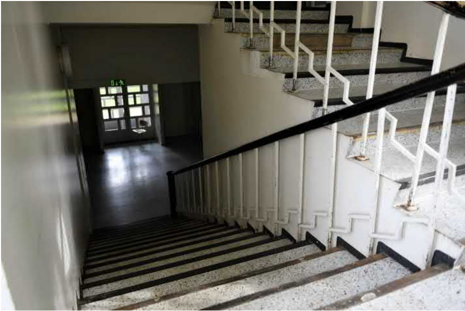
Kuva: Pääporras aulasta II-kerrokseen. Portaat mosaiikkibetonia.
