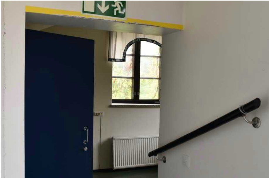
Kuva: Porrashuoneen kellarikerros.
