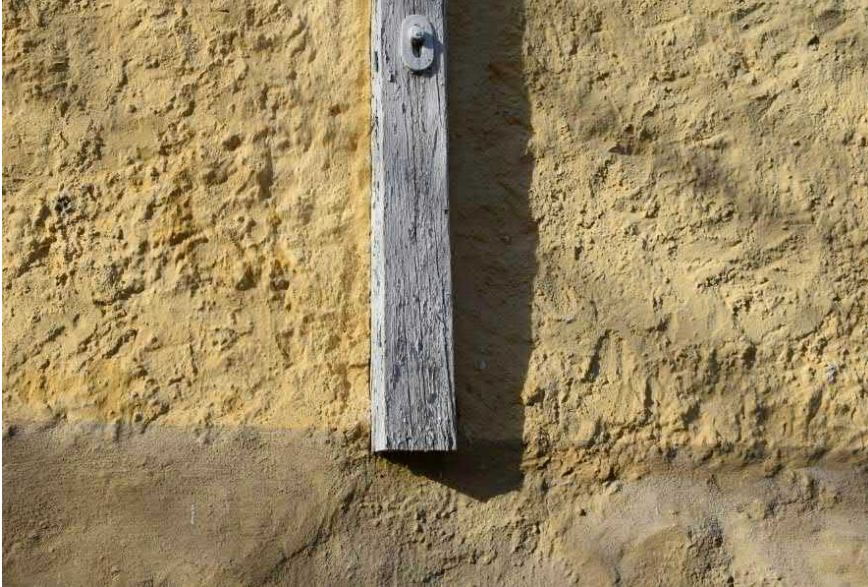
Kuva: Rakennuksen pitkällä sivuilla on keskimmäisen ikkunan molemmin puolin hirsinen följäri. Tällä kohtaa seinää on kolmen hyvin lähekkäin sijoitettua ikkunaa.
