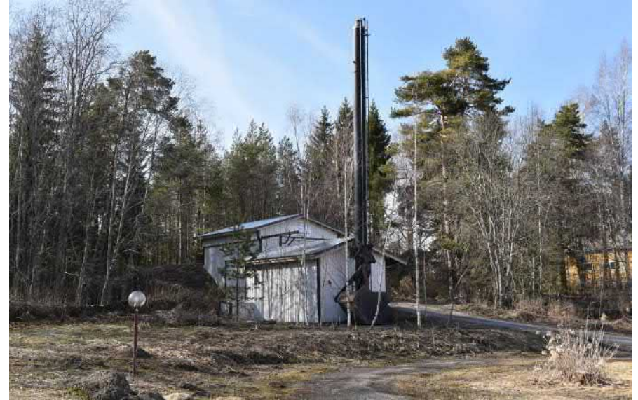
Kuva: Lehtiniemen lämpölaitos tuottaa hakkeella kaukolämpöä. Kohteena on ollut yhteensä 10 rakennusta. Rakennus on puutarhan kulmalla, kiviaidan luona. Teho:0,4 MW, Tyyppi: stokeri + porrasarina + liikkuva arinakoneikko. Laitetoimitus: Biofire Oy. Valmistusvuosi 2004.
