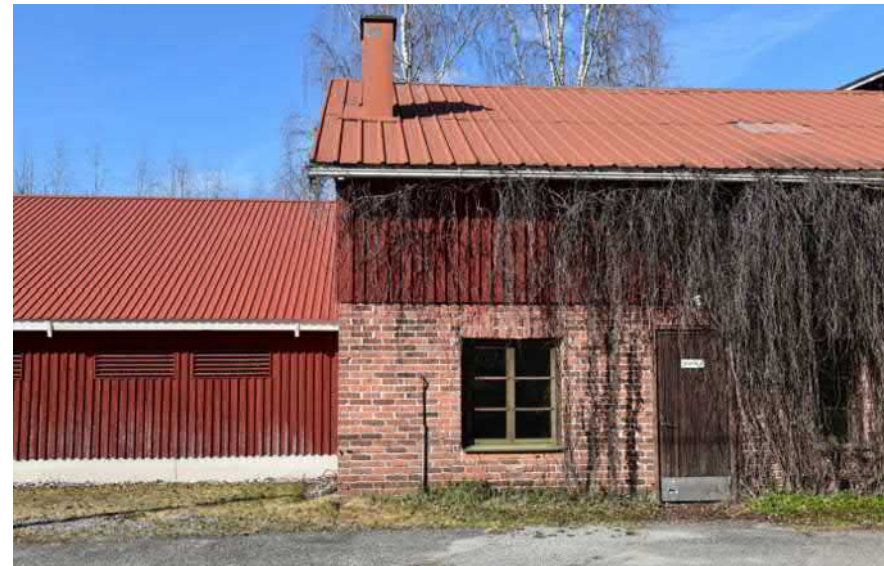
Kuva: Kuvassa näkyvä tiiliseinäinen länsipäätty on entistä sikalaa.
