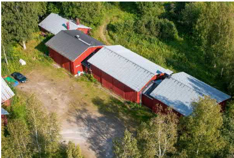
Kuva: Rakennusrivin tummakattoinen osa on konevarasto (1992) ja vaaleakattoiset käsittävät kuivaamon ja kalustovaja (1983). Perällä näkyvä kellari on vanhempi.
