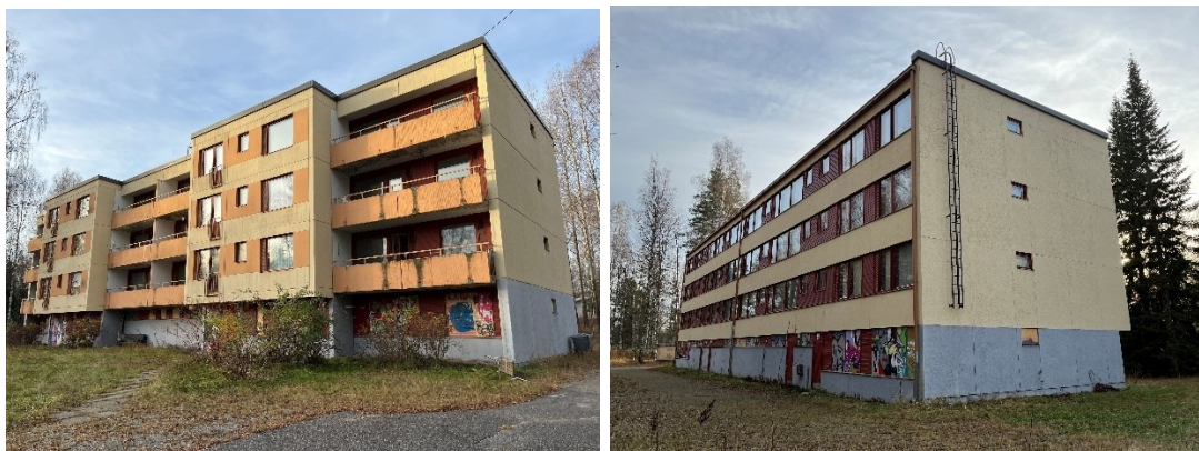
Kuva 18. Alueella sijaitsee kaksi tyhjiään olevaa kerrostaloa, jotka kaupungin tarkoitus purkaa vuoden 2025 aikana.
