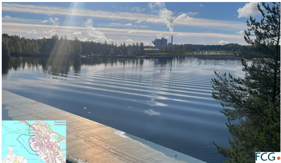
Kuva 37. Näkymä pohjoisesta. (FCG, 2025)
