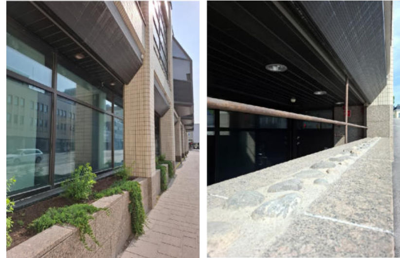
Kuva 20. Istutuskaukalot Olavinkadulta. Kirkkokadun puolella kaukalo ummistettu.
