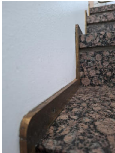
Kuva 24. Porras 1-2. kerroksen välillä. Messinkiset kaiteet ja jalkalistat.
