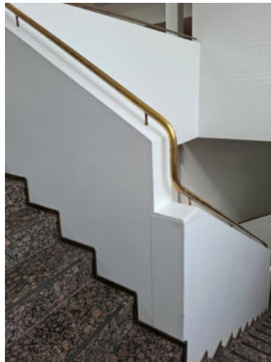
Kuva 24. Porras 1-2. kerroksen välillä. Messinkiset kaiteet ja jalkalistat.
