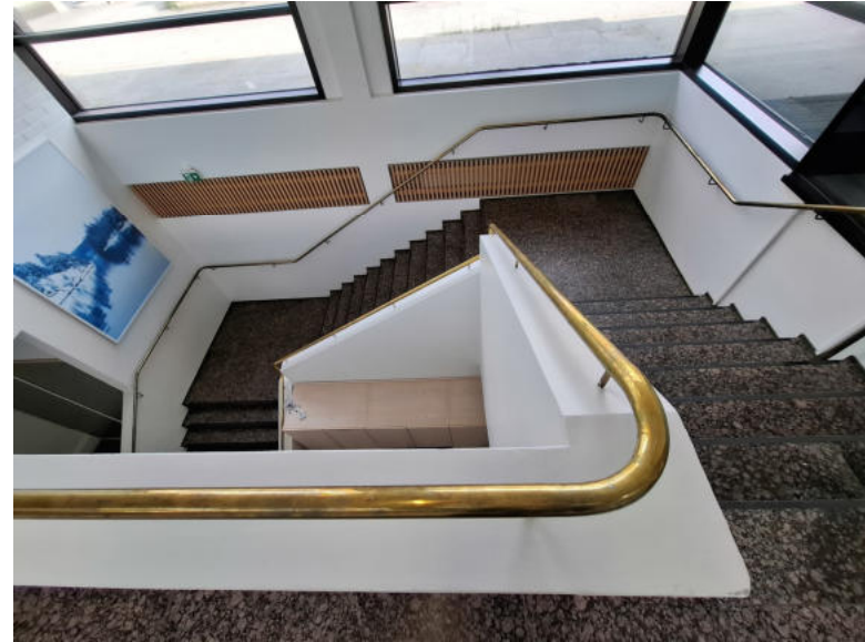
Kuva 25. Porras 1-2. kerroksen välillä. Taustalla pattereiden peittämät tammisäleiköt.
