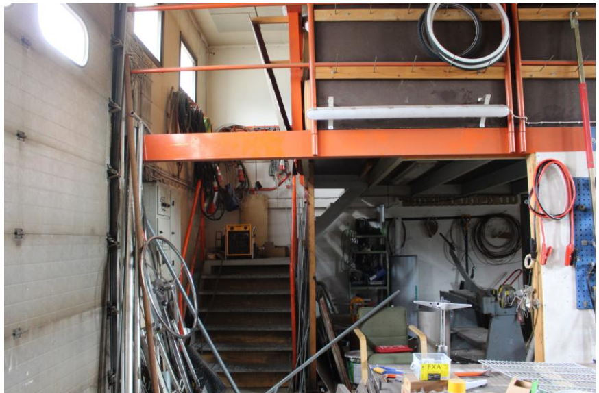
Keskimmäisessä hallilohkossa on varastotilaa parvella.
