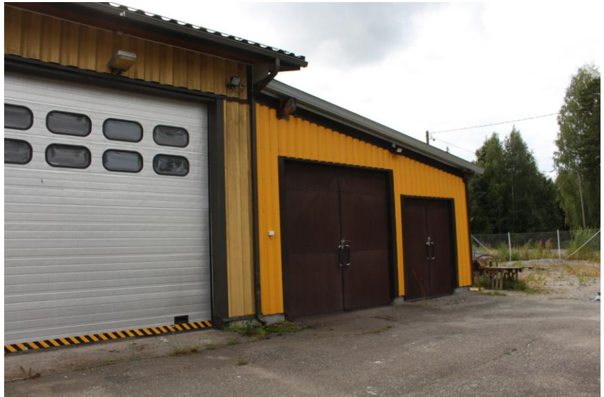
Rakennukseen on viimeisimpänä laajennuksena tehty varastotila.
