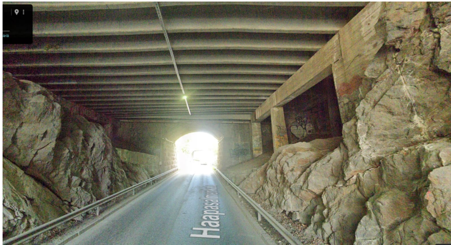
Kuva 13: Kallioleikkaukset ja paikoituskannen TT-palkisto alta nähtynä
