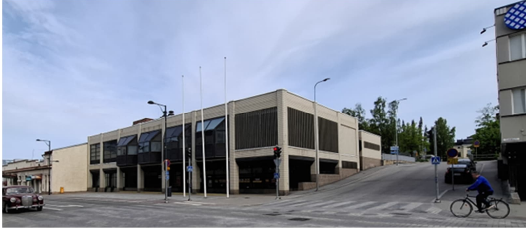
Kuva 10: Nykyinen rakennus Olavinkadun ja Kirkkokadun kulmassa.
