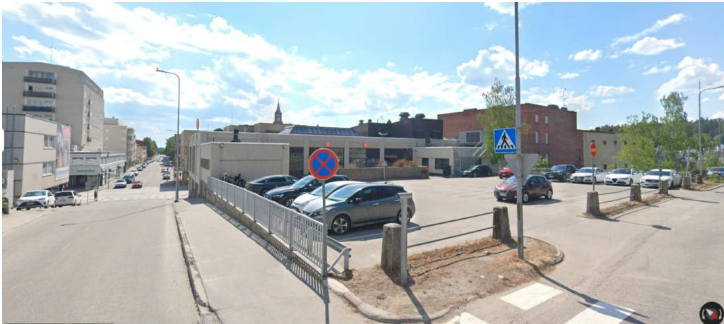
Kuva 11: Nykyinen pankkirakennus paikoituskansineen nähtynä Kirkkokadun ja Piispanrinteen kulmasta. Etualalla paikoituskannen raja-aidat.
