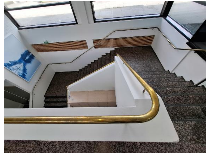
Kuva 22. Porras 1-2. kerroksen välillä. Taustalla pattereiden peittämät tammisäleiköt.
