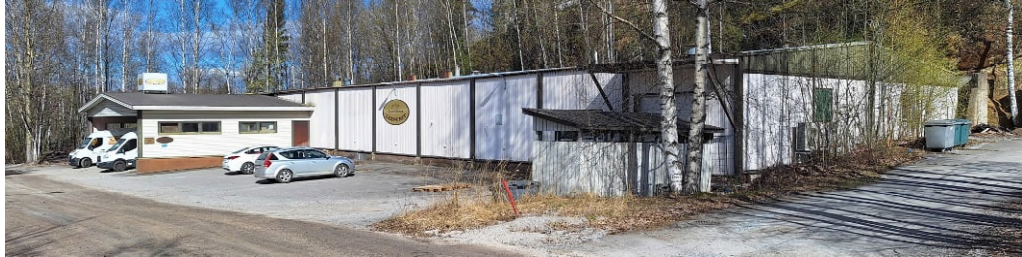
Savonlinnan Sokerileipomo Oy:n teollisuusrakennus.
