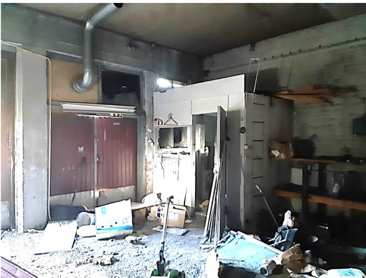
Kattila- ja konehuone. 1. kerros, entinen kattilahuone. 2024.
