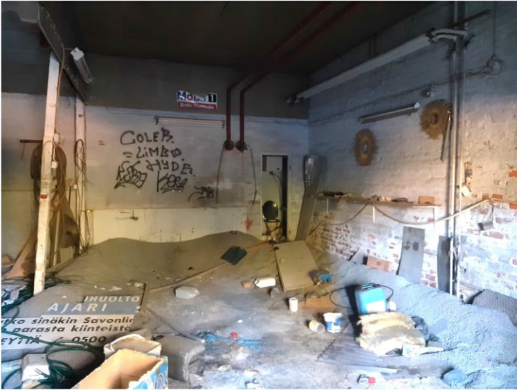
Kattila- ja konehuone. 1. kerros, entinen kattilahuone. 2024.
