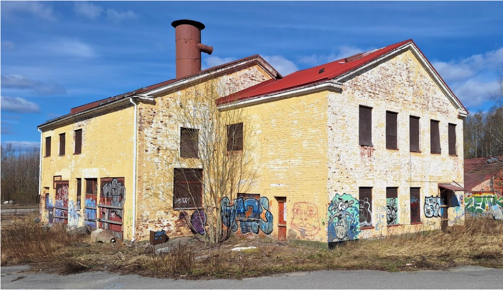
Kattila- ja konehuone. 2024.
