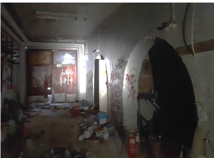
Kattila- ja konehuone. 1. kerros, entinen konehuone. 2024.
