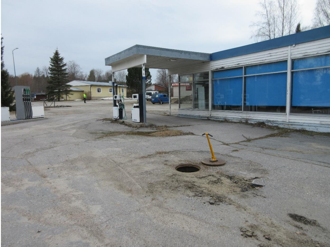
Kuva 7. Öljynerottimen sijainti.
