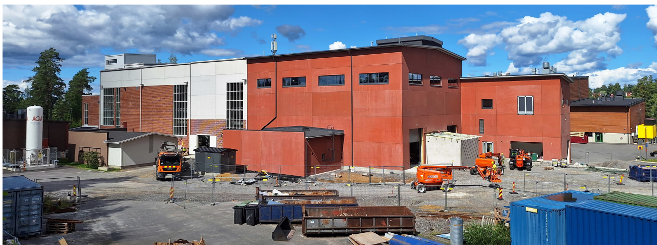
Kuitu II laajennus. Heinäkuu 2026
