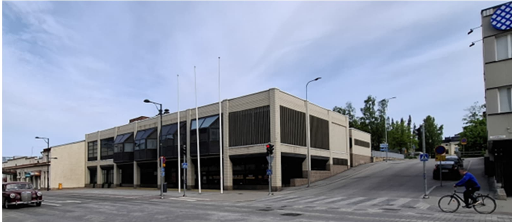
Kuva 10: Nykyinen rakennus Olavinkadun ja Kirkkokadun kulmassa.
