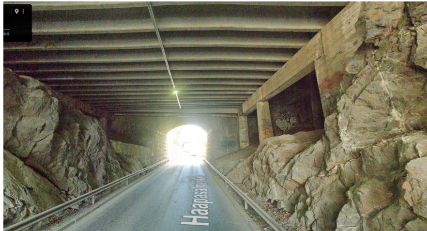
Kuva 13: Kallioleikkaukset ja paikoituskannen TT-palkisto alta nähtynä
