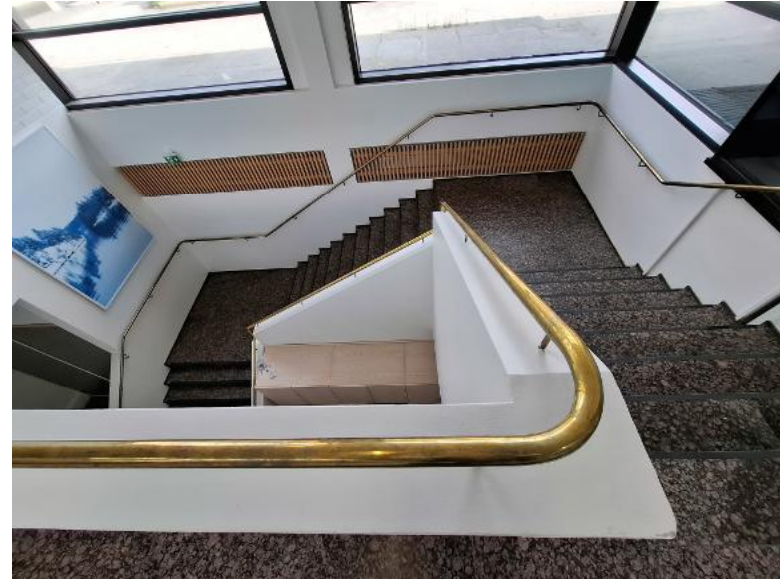
Kuva 22. Porras 1-2. kerroksen välillä. Taustalla pattereiden peittämät tammisäleiköt.
